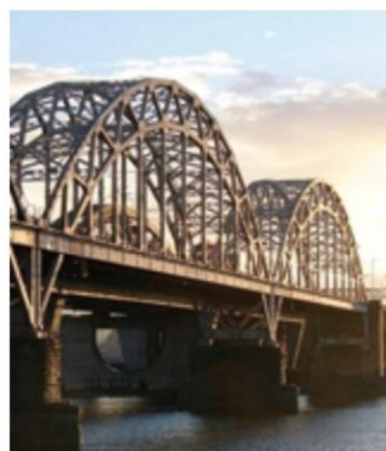
Дарницький міст через р. Дніпро
