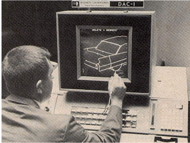
Мал. 19. DAC-1 дозволяла виробляти проектування різних об'єктів, наприклад автомобілів, переглядати зображення з різних ракурсів.
